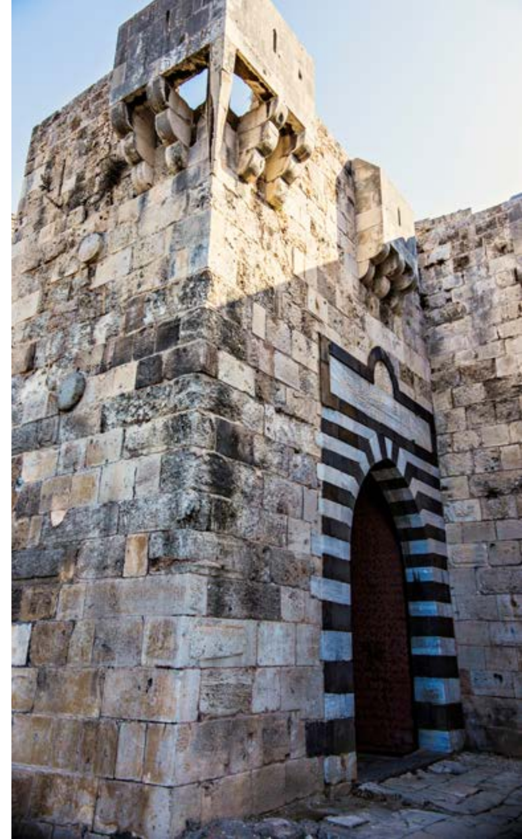
Raymond de Saint-Gilles Kalesi'nin Duvarları Walls of The Citadel of Raymond de Saint-Gilles.
